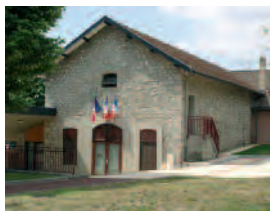
2- L'ancien dépôt de wagons est devenu la première salle des fêtes de Crolles en 1930. Aujourd'hui c'est un boudrome.
